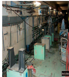
ALS before dismantling
